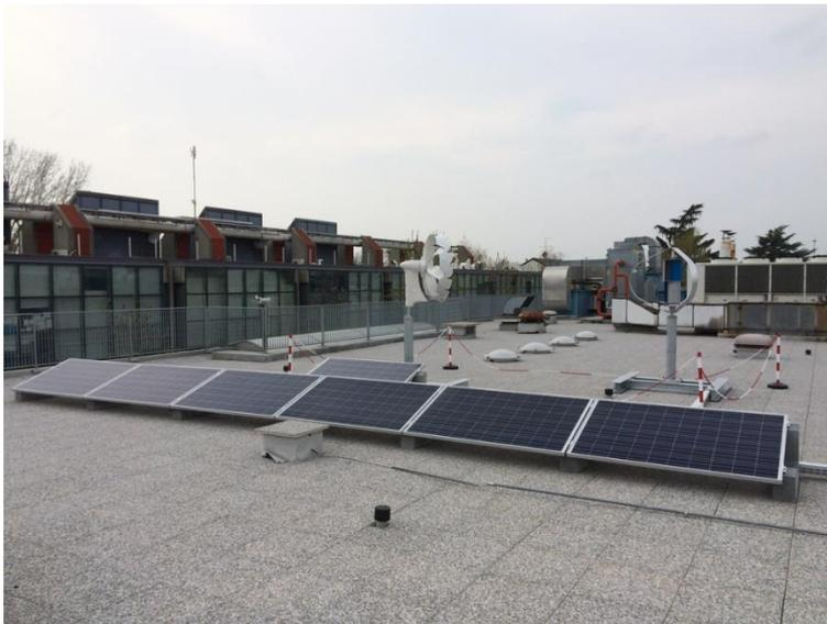
1,56kW di fv + 300W di eolico
